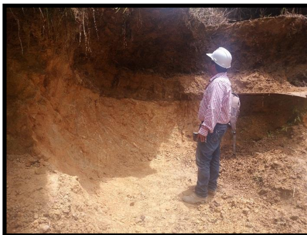
Imagen 23 Frente de explotación inactivo de la UPM 0339-73, compuesto por rocas hipoabisales (Tad). Fuente: Grupo Formalización Minera 2017.
