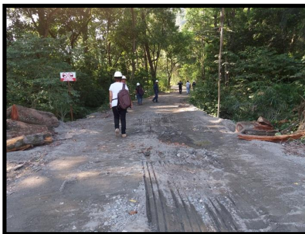
Imagen 38. Vía de acceso a la Minas San Pedro. Fuente: Grupo de Formalización minera, 2017.
